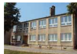
Szkoła w Grobli przed termomodernizacją...
