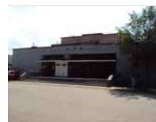
Budynek GCKiP przed termomodernizacją...
