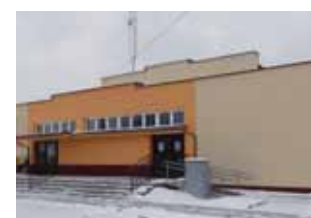
...i po remoncie
