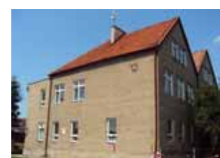
Szkoła w Dziewinie przed termomodernizacją...
