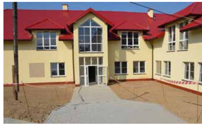
Budowa przedszkola i gimnazjum w Lipnicy Murowanej
