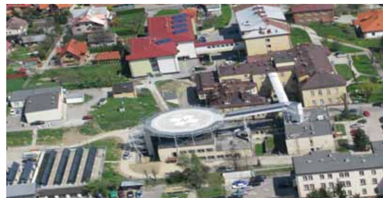
Lądowisko dla helikopterów przy Szpitalu Powiatowym w Bochni
