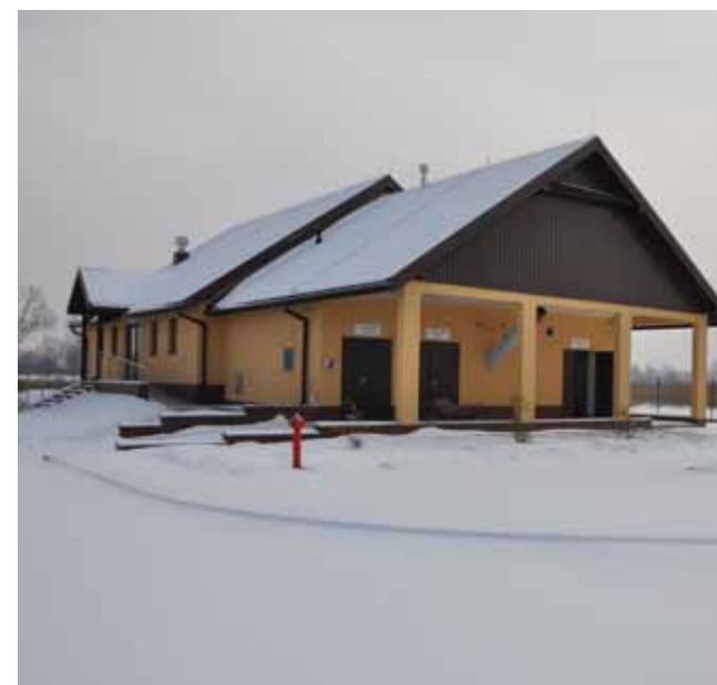
Oczyszczalnia w Okulicach
